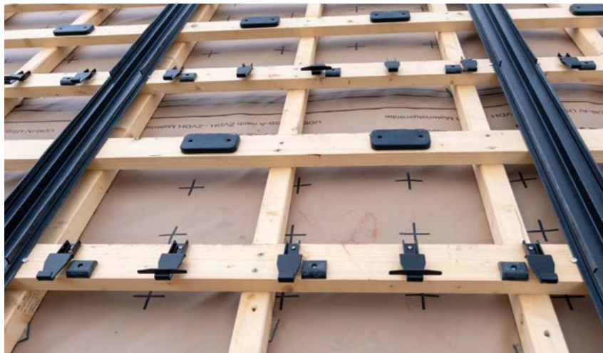
Sottostruttura della soluzione Alpin+ di 3S: cinque ganci Alpin e in questo caso due supporti in gomma consentono l'impiego del tetto TeraSlate anche in regioni alpine a quote elevate.
