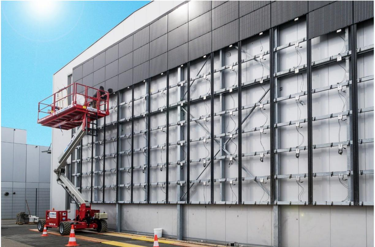
Abbildung 16: 3S Solarfassade mit Alu-Modullattung und Träger-Unterkonstruktion
