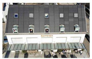
Bedingt durch den Herstellungsprozess des satinierten Glases sind je nach Betrachtungswinkel Abweichungen hinsichtlich der Farbe möglich. Dies kann dazu führen, dass nicht alle Solarmodule gleich aussehen. Die Abweichungen sind rein optischer Natur und haben keinen Einfluss auf die Leistungsfähigkeit des Moduls.
