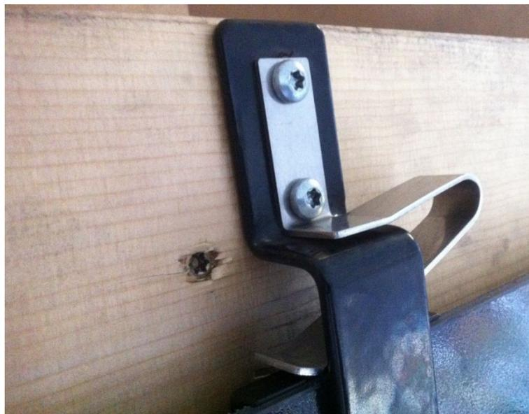
Fig. 4: Molla di bloccaggio, montata
