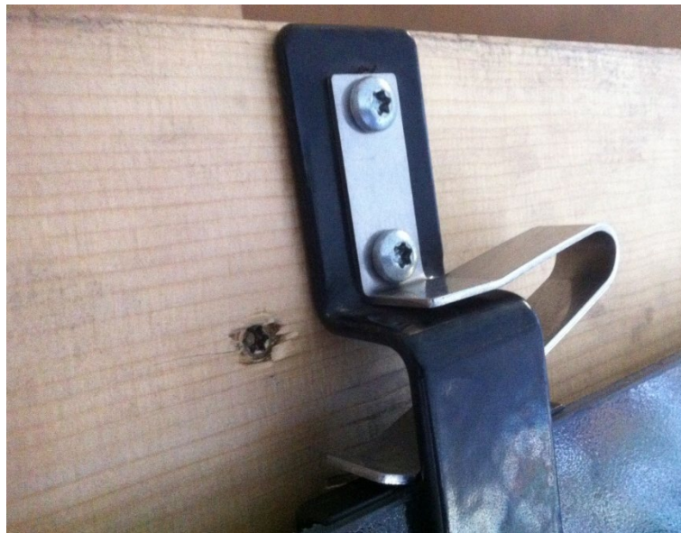
Abb. 4: Sicherungsfeder, montiert
