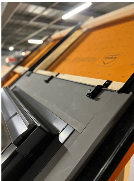
Profilés d'insertion montés sur le côté et en haut
