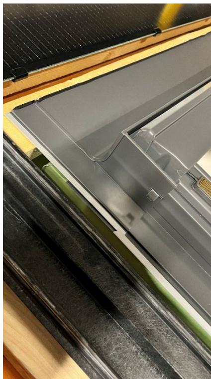
Raccord ODL tête sans profilés d'insertion
