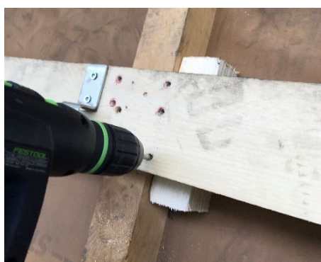
Immagine 10 preforatura dei fori di montaggio
