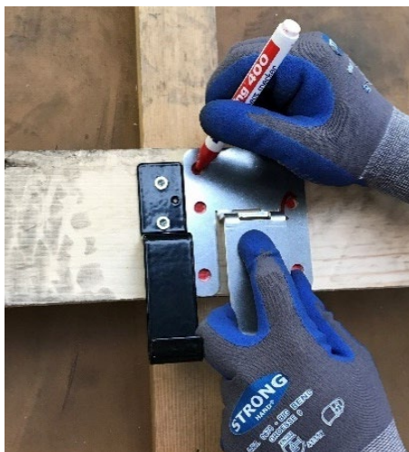
Immagine 9 marcatura dei fori di montaggio
