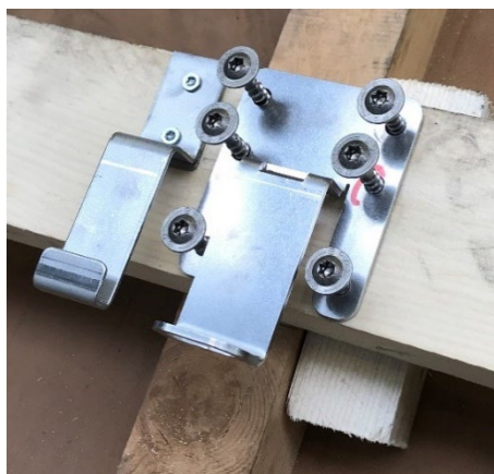
Immagine 11 inserimento delle viti di montaggio
