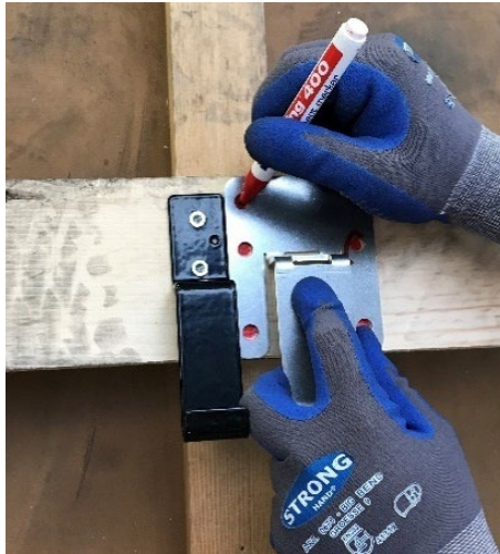
Immagine 9 marcatura dei fori di montaggio
