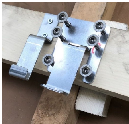
Immagine 11 inserimento delle viti di montaggio
