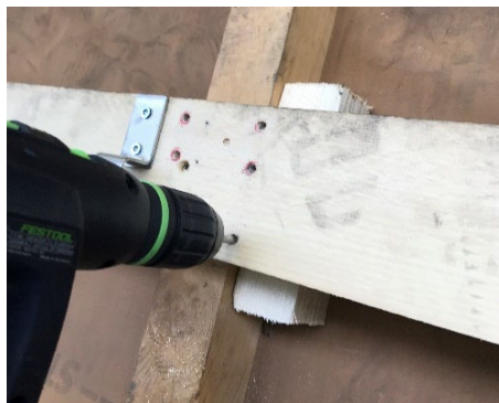
Immagine 10 preforatura dei fori di montaggio
