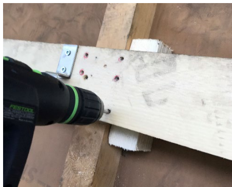
Illustration 10 Pré-percer les trous de montage
