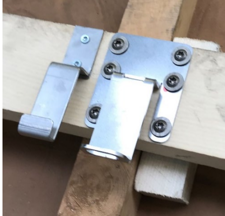
Illustration 12 Vis de montage serrées
