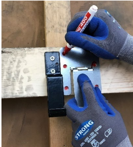
Illustration 9 Tracer les trous de montage
