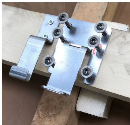
Illustration 11 Placer les vis de montage
