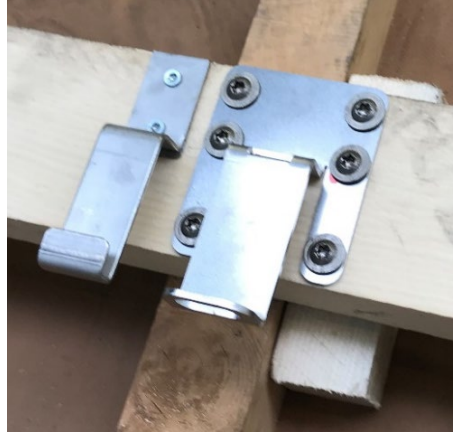
Abbildung 12 Angezogene Montageschrauben
