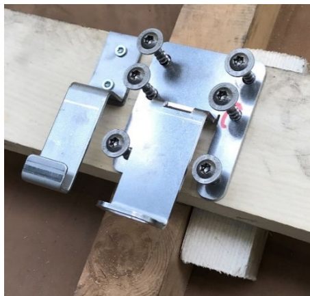
Abbildung 11 Montageschrauben setzen
