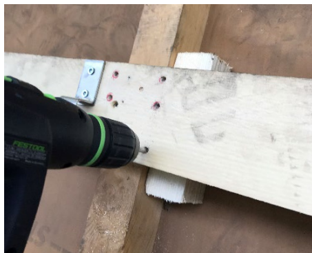
Abbildung 10 Montagelöcher vorbohren
