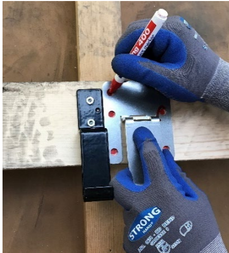
Abbildung 9 Montagelöcher markieren
