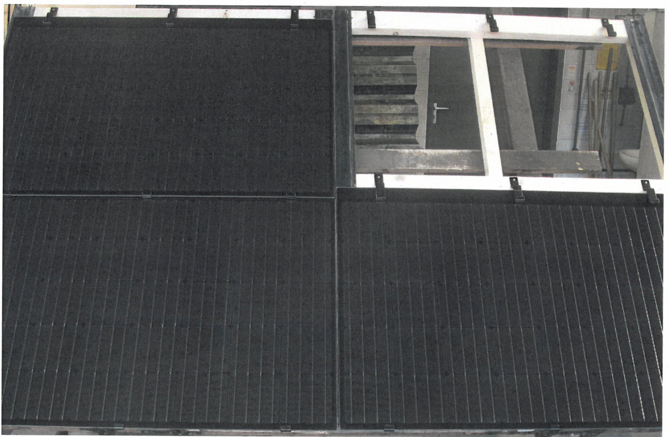
Aufbau der Bedachung mit Solarmodulen Built-up of the roofing-system with solarmodules
