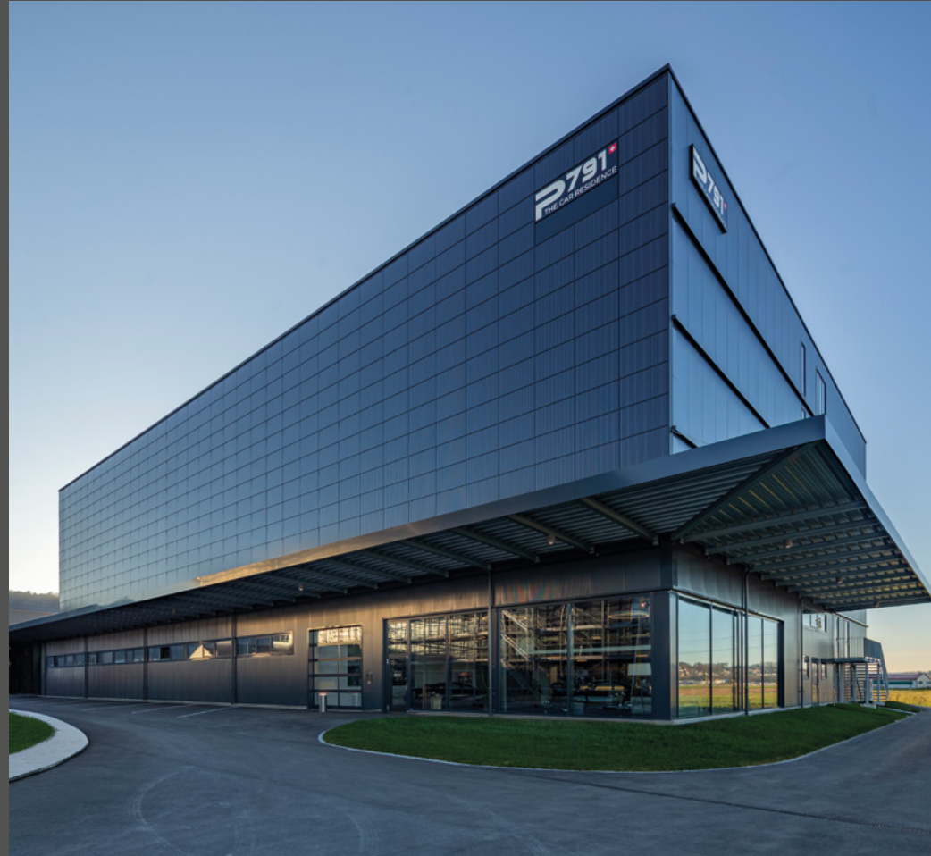
Façade solaire 3S
