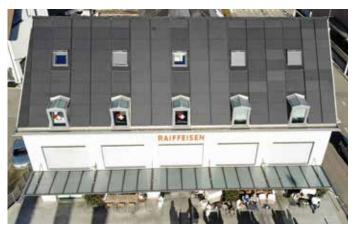
Bedingt durch den Herstellungsprozess des satinierten Glases sind je nach Betrachtungswinkel Abweichungen hinsichtlich der Farbe möglich. Dies kann dazu führen, dass nicht alle Solarmodule gleich aussehen.
