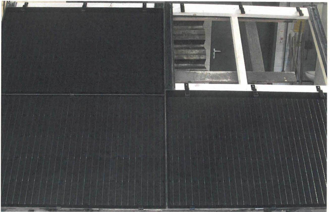
**Aufbau der Bedachung mit Solarmodulen**
