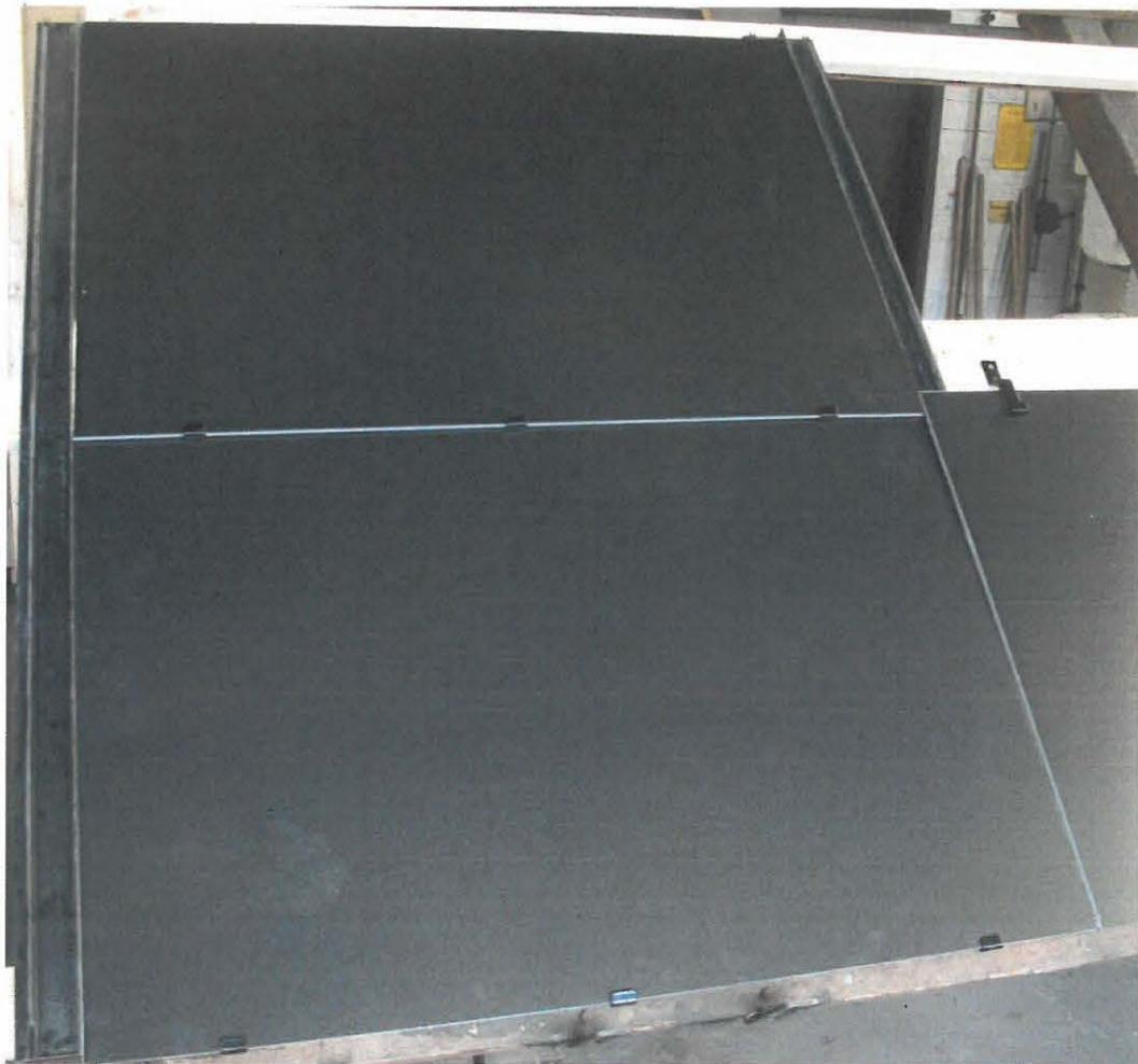
**Aufbau der Bedachung mit Aluminium-Verbundplatten**
