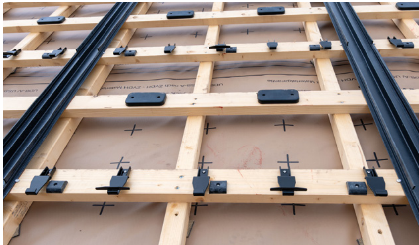
Unterkonstruktion der 3S Alpin+ Lösung: Fünf Alpin-Haken und in diesem Fall zwei Auflagegummis ermöglichen den Einsatz des 3S Solardachs auch in hochalpinen Regionen.
