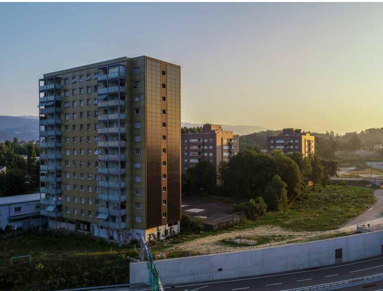
**In den 70er Jahren wurden in der Schweiz zahlreiche Hochhäuser gebaut, darunter auch der Wohnturm an der Aegertenstrasse 36 in Biel. Nach einem hochwertigen Fassaden-Facelifting mit integrierter Solarstromanlage made by 3S aus Thun strahlt das Gebäude heute ein Stück Modernität aus und liefert seinen Bewohnerinnen und Bewohnern bis zu 50% ihres Stromverbrauchs.**
