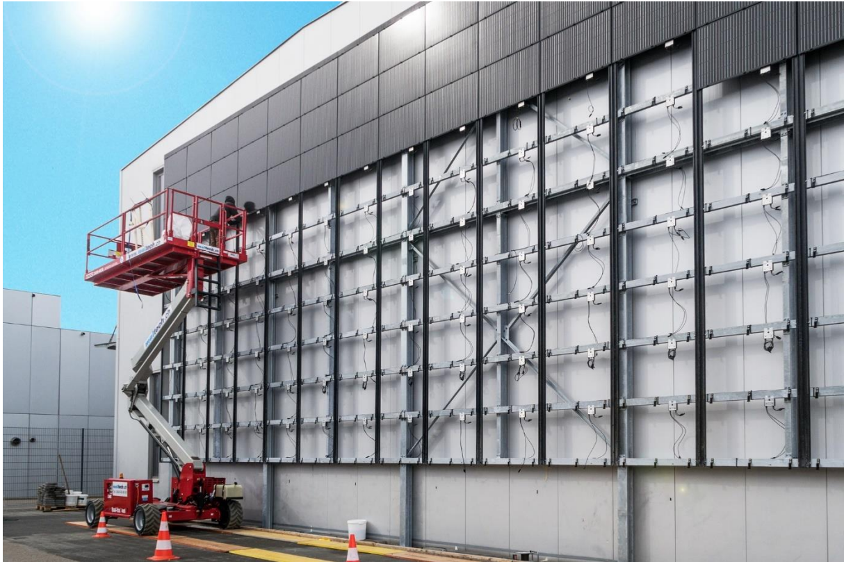
Illustration 7: Façade MegaSlate II avec lattis de module en aluminium et sous-structure en profilés d'acier
