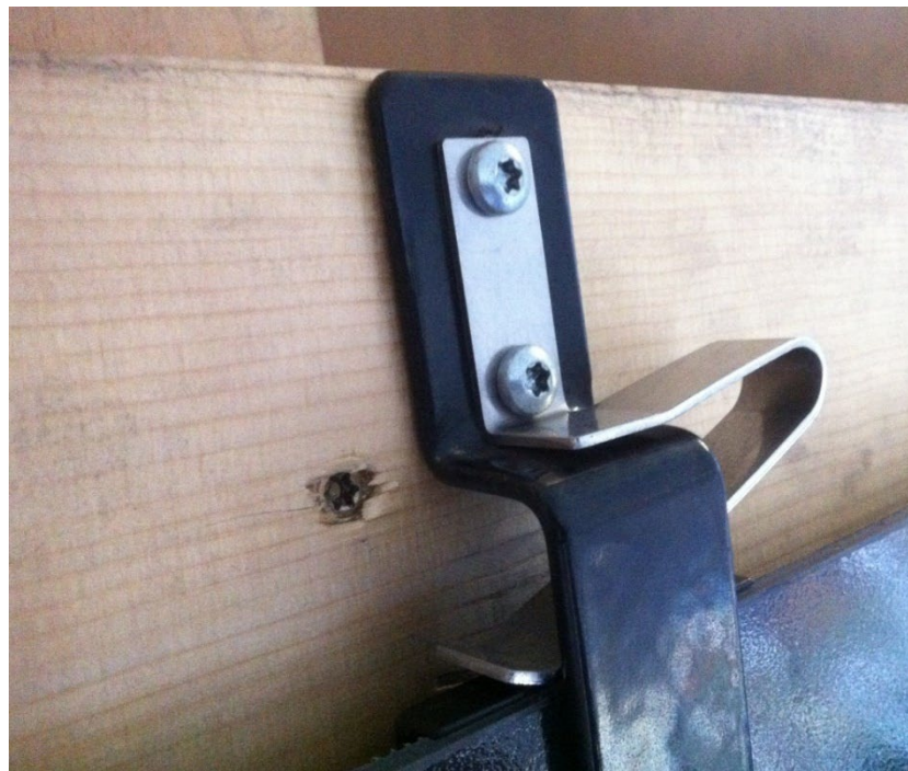
Figure 38 Ressort à lame, installé
