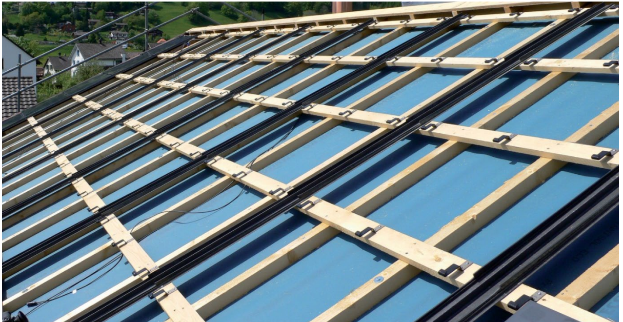
Figure 20 Sous-structure PV MegaSlate posée (exemple sans conduites pour les câbles)
