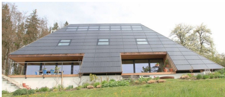
Figure 1 Tuiles solaires MegaSlate intégrées dans la toiture
