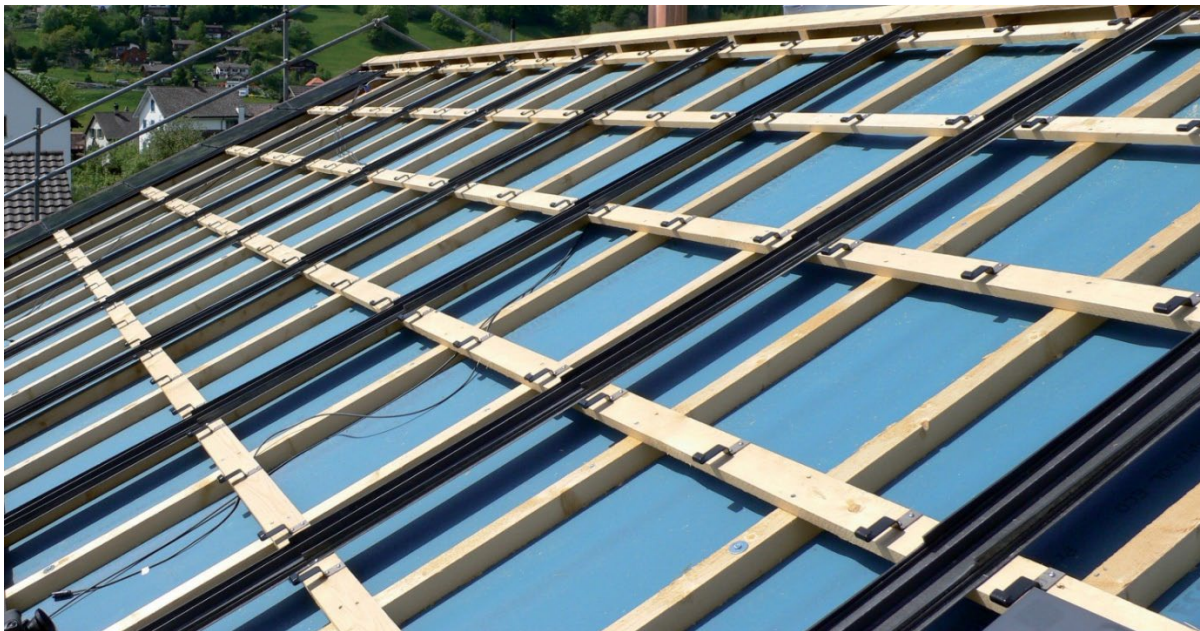
Abbildung 21 Verlegte MegaSlate Unterkonstruktion ( Abbildung ohne Kabelkanäle für die Strangkabel)
