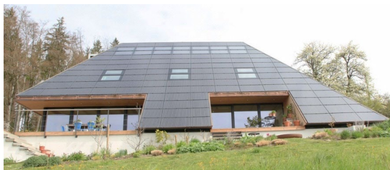
Abbildung 1 Komplette Dacheindeckung mit MegaSlate
