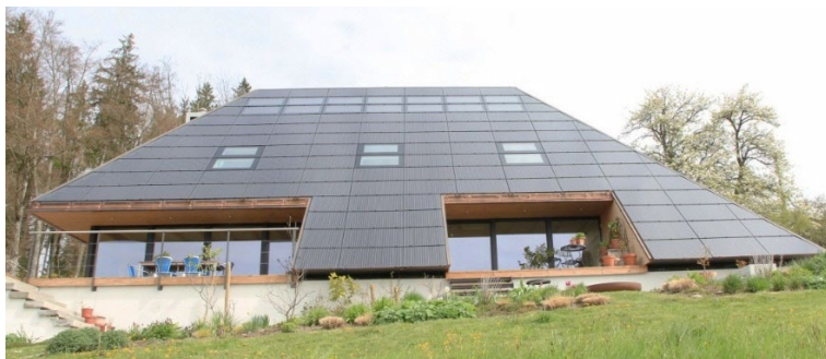
Immagine1 Copertura del tetto intera con MegaSlate
