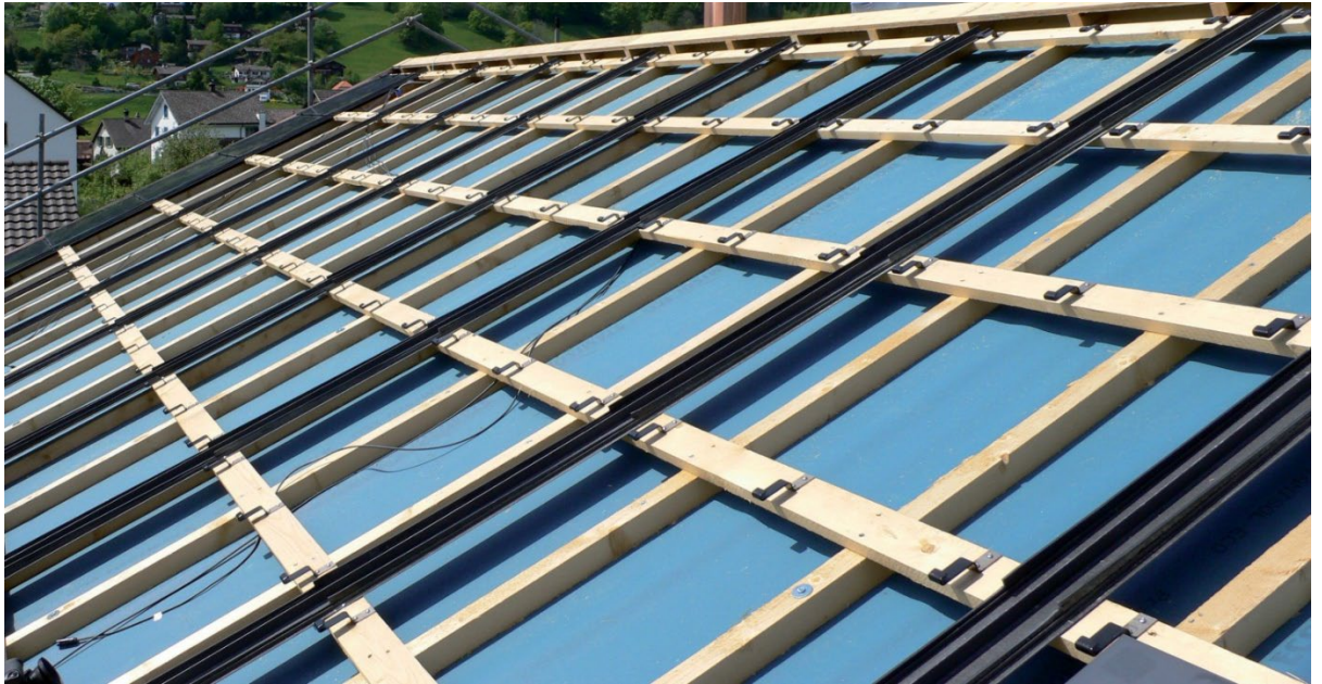
Immagine 21 Sottostruttura MegaSlate installata (immagine senza canali per i cavi di stringa)
