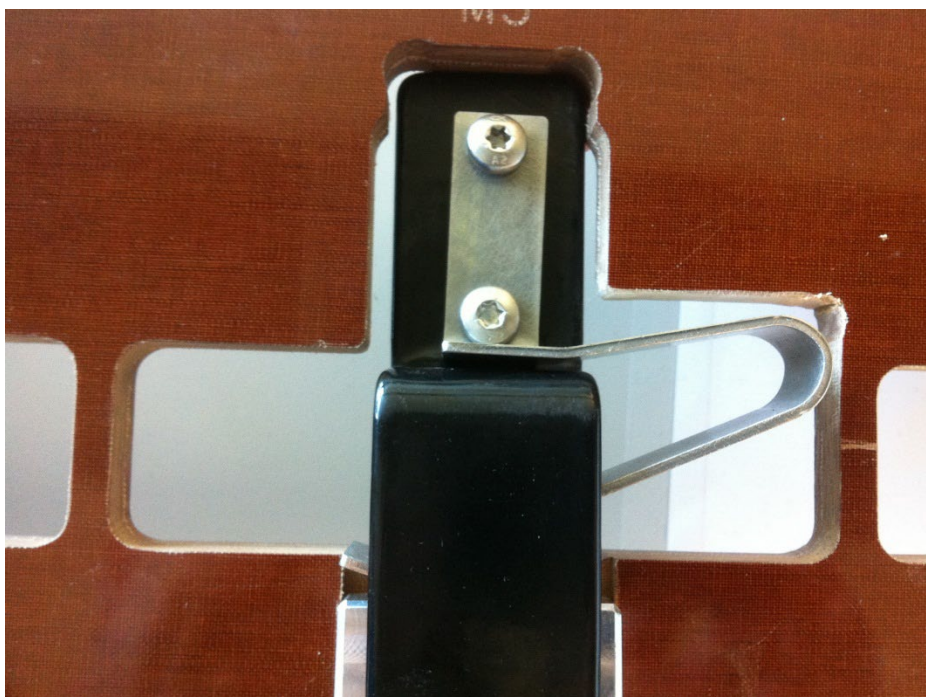
Immagine 40 Guida per il montaggio MegaSlate con ritaglio nel gancio intermedio
