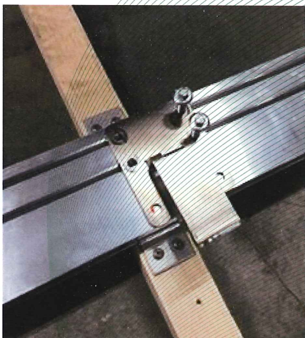
Bild 1: Anschlageinrichtung, Typ: MegaSlate® II Anschlageinrichtung (MS-AE), montiert auf einer Holz-/ Aluminiumunterkonstruktion
