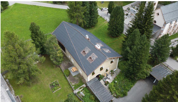
Ein Engadinerhaus in Graubünden erhielt einen Sondersolarpreis. Markant ist die «Bruchlinie» im Dach, die aufgrund der Windschiefe notwendig wurde, um eine planebene Montagefläche zu erzielen.
