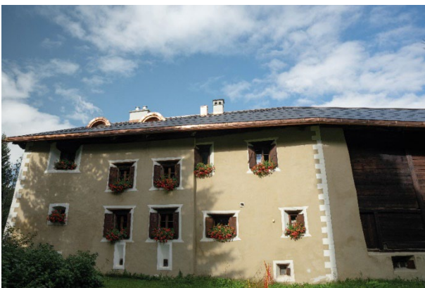
Ein Engadinerhaus in Graubünden erhielt einen Sondersolarpreis. Markant ist die «Bruchlinie» im Dach, die aufgrund der Windschiefe notwendig wurde, um eine planebene Montagefläche zu erzielen.
