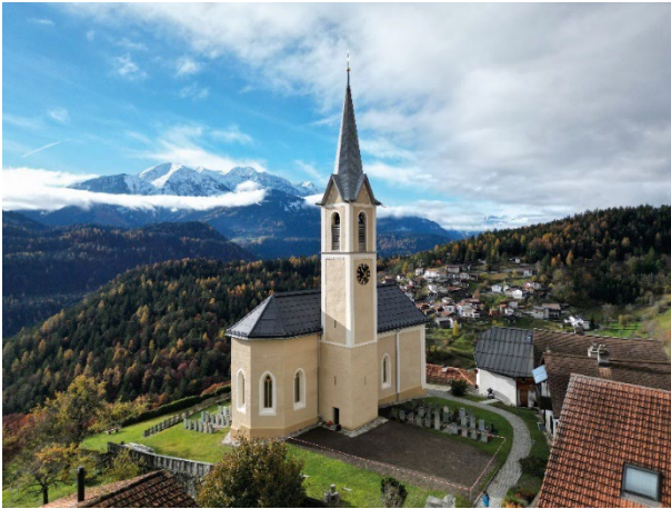
Trotz einzigartiger Dachform und Linienführung konnte das gesamte Kirchendach vollflächig belegt werden.
