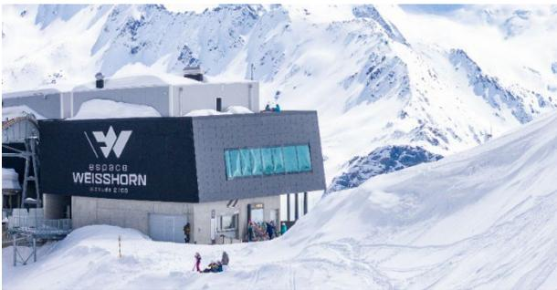
Die elegante 3S Solarfassade erfüllt hohe Ansprüche an die Ästhetik, ist nachhaltig und robust. Sie unterstützt besonders im Winter maximale Energieerträge und bietet einen optimalen Witterungsschutz. Das TeraSlate Fassadenmodul bietet dank der Glas-Glas-Ausführung Vorteile in den Bereichen Brandschutz und Resttragfähigkeit, dank der abZ ist der Einsatz auch ohne Zustimmungen im Einzelfall möglich.
