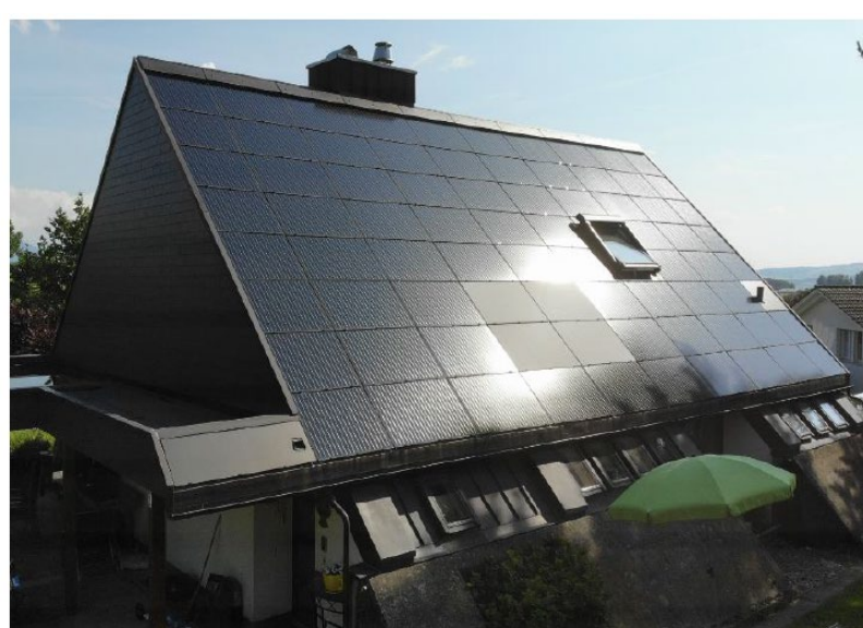
Immagine 5: campionatura di 4 moduli FV antiabbagliamento
