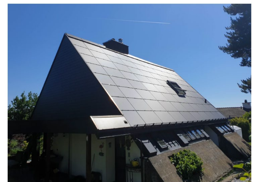
Immagine 6: superficie del tetto dopo la ristrutturazione
