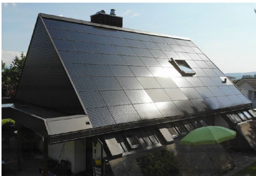
Figure 5: Échantillonnage 4 modules PV anti-éblouissement
