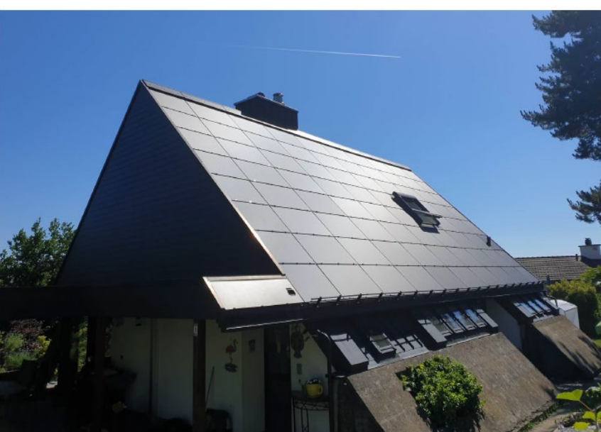
Figure 6: Surface du toit après la rénovation
