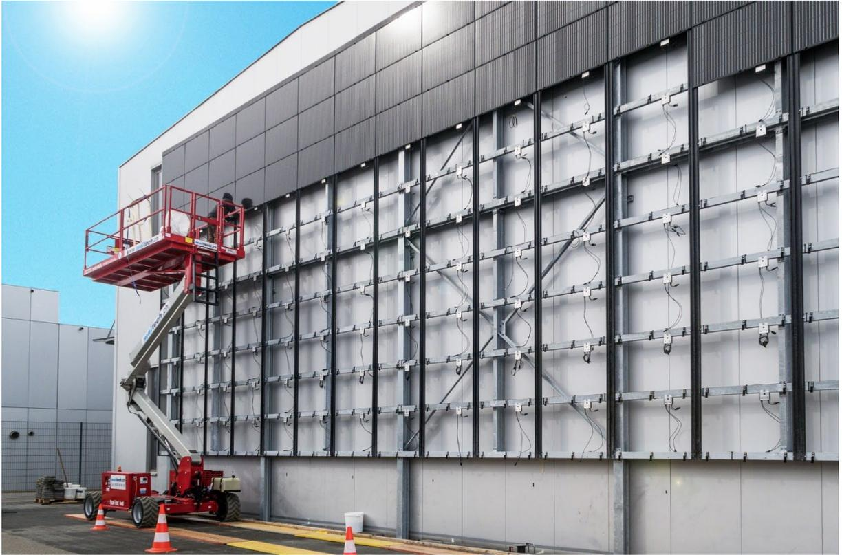
*Immagine 9: facciata TeraSlate con listellatura modulare in alluminio e sottostruttura in profilato d'acciaio*
