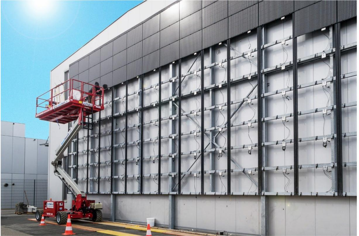
*Illustration 9: Façade TeraSlate avec lattis de module en aluminium et sous-structure en profilés d'acier*
