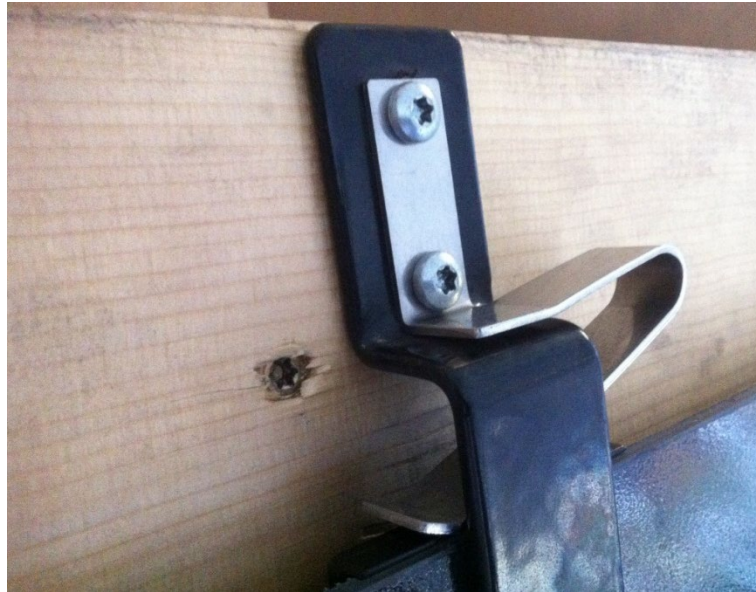
Abbildung 11: Sicherungsfeder, montiert
